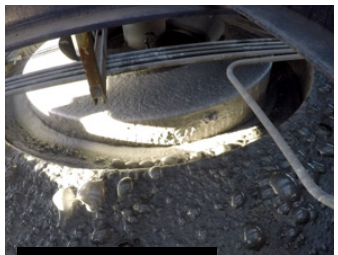
Después del retrofit
