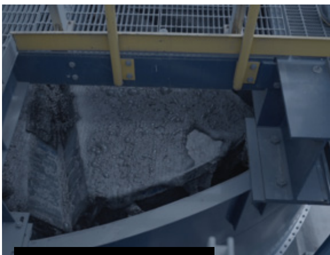
Antes del retrofit
