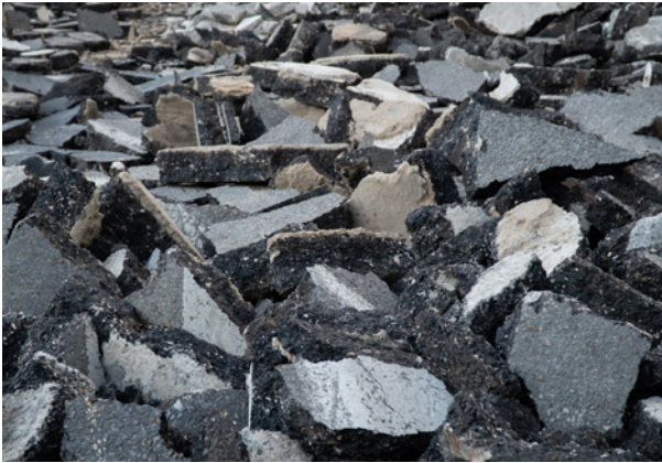
Recyclage de l'asphalte
