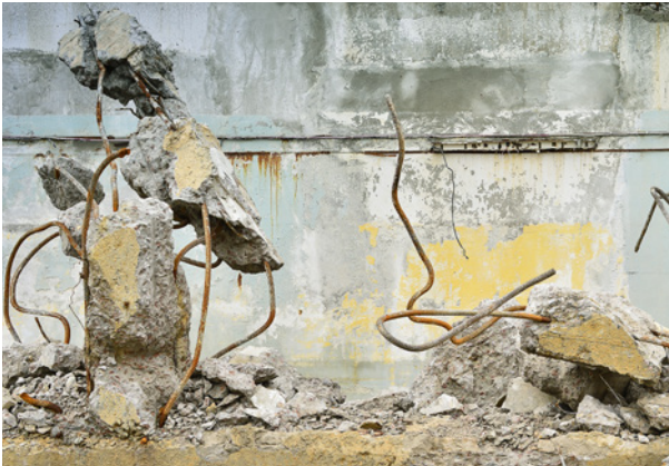
Béton de démolition
