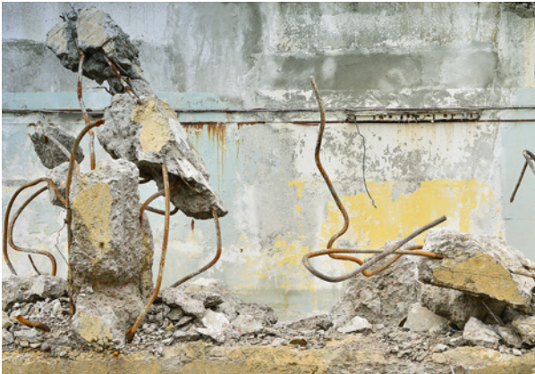
Demolição de betão
