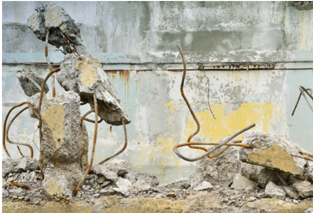
Hormigón de demolición
