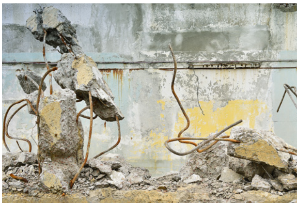
Rozbiórka konstrukcji betonowych
