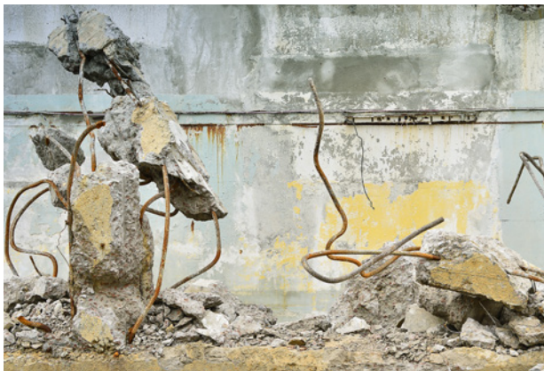
Снос бетонных конструкций
